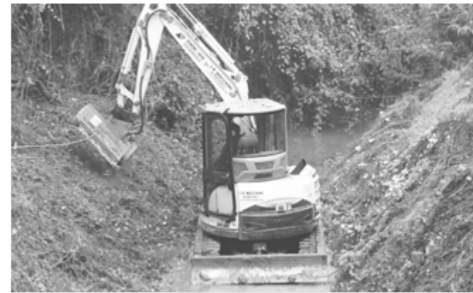
I lavori sul Grue.
